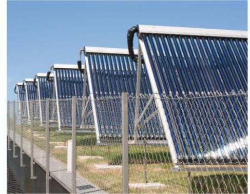
Un impianto solare termico prevede anche la possibilità di applicare la tecnologia del *solar cooling*, cioè l'abbinamento a macchine frigorifere per la produzione del freddo, sotto forma di acqua refrigerata o aria condizionata, che permette di utilizzare l'acqua calda prodotta dai collettori solari anche nella stagione estiva, utile per la refrigerazione e il condizionamento degli ambienti
