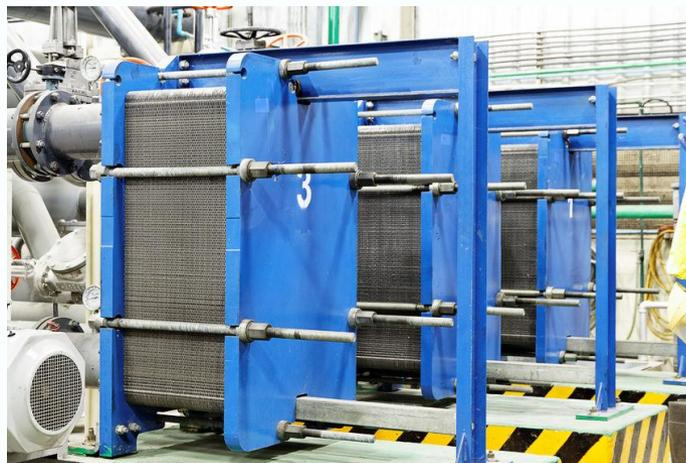
In questo modo è possibile valorizzare il calore di scarto nel momento stesso in cui si provvede a dissiparlo, utilizzandolo per altri scopi, come il riscaldamento degli ambienti, il riscaldamento dell'acqua sanitaria, il preriscaldamento dei fluidi ecc., riducendo lo spreco di combustibile primario, i costi e le emissioni di Co2.
